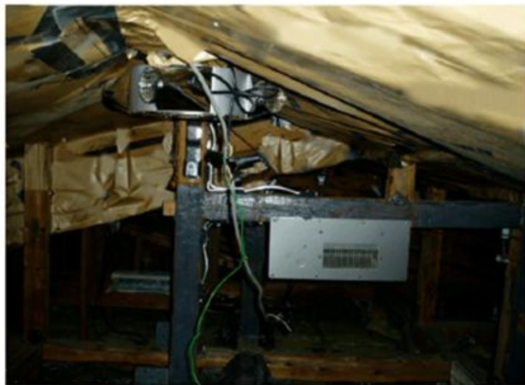
写真⑧：攪拌機および換気扇の設置
