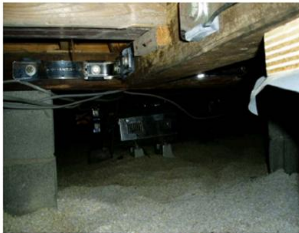
写真⑥：金物の取付、攪拌機の設置
