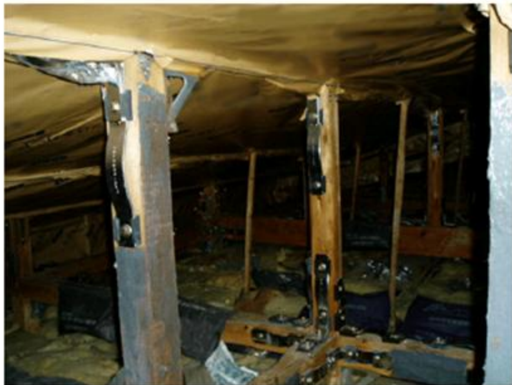
写真⑦：金物の取付、調湿剤の設置
